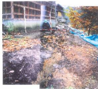
① 調査計器設置を始める現場写真
